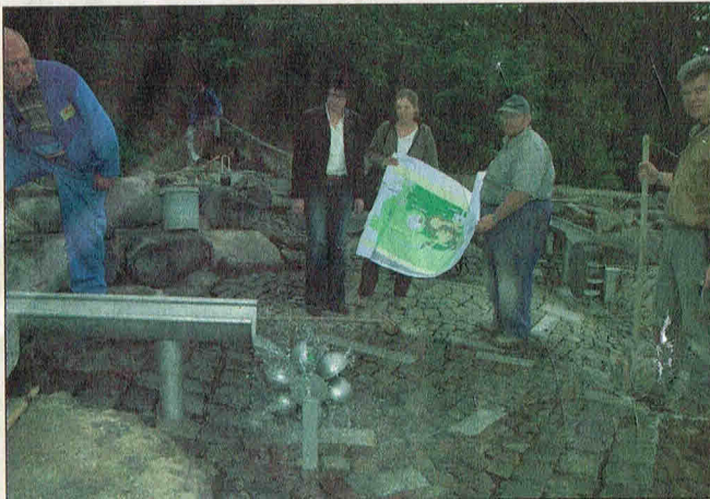
Bei der Baustellenbesichtigung (v.l.) Ortsbürgermeister Werner Ihrig, Bürgermeisterin Anette Moesta, Landschaftsarchitektin Dipl.-Ing. Regine Eckenroth und Vertreter der ausführenden Firma.
